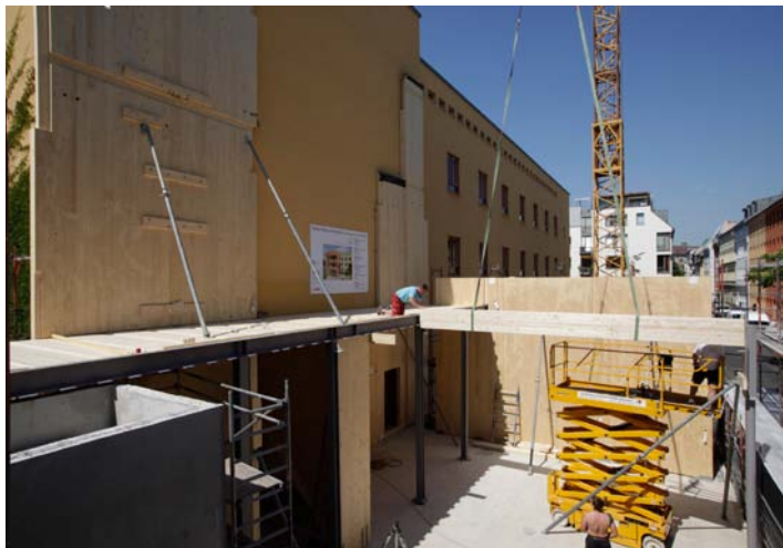
Einsetzen eines Balkens in eine Stahlstütze
